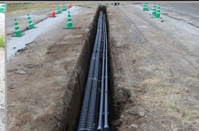
トレンチャー掘削後の管理設
