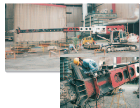
自社製転炉解体機のフィールドサービス
