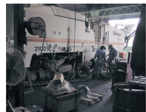
大型道路切削機の修理
