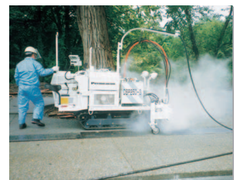
ウォータージェットによる先端作業機的设计製作
