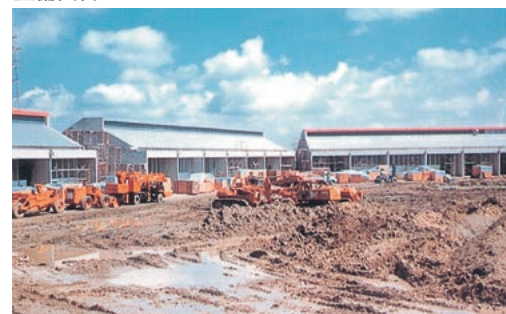
整備工場等の建設
