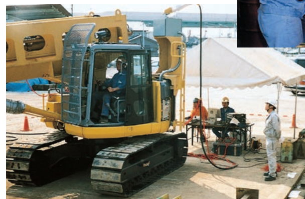
転炉解体機の応力テスト
