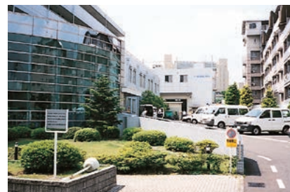
東京工場:敷地3,700m 2
