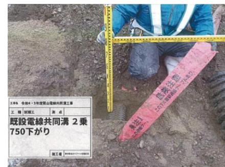
電線共同溝 2条 深さ750mm
