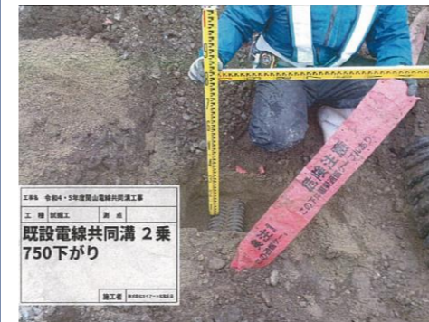
電線共同溝 2条 深さ750mm
